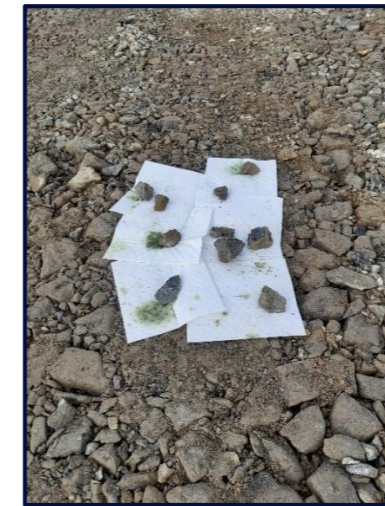
Figure 3 : Mise en place de papier absorbant d'un kit anti-pollution après détection d'une fuite d'engin (Source : SAFEGE, 2022)
