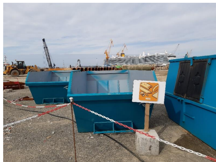
Figure 50 : Exemple de mise en place de bennes distinctes sur le chantier du développement du Port de Brest (Source 2022)
